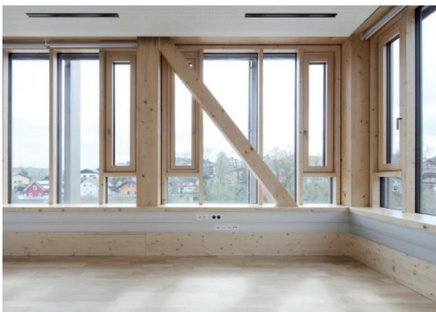
Damit ein Umbau einfach möglich ist, wurden die Installationen eigens in die Parapete verlegt und sämtliche Zwischenwände installationsfrei ausgeführt.
